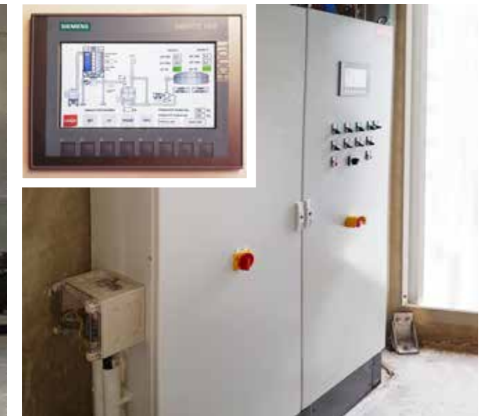
Schaltschrank mit integriertem Touch- Panel
